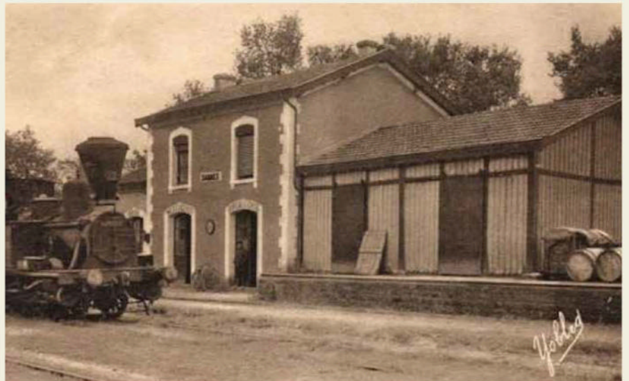
Devant le BV, une typique 030 T de Gironde, équipée d'un pare-escarbilles.
