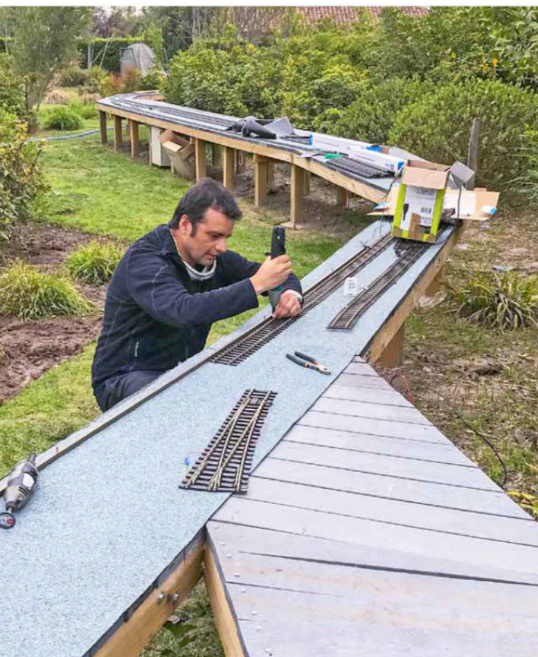
La plateforme de la voie est construite comme une terrasse d'extérieur sur pilotis.
