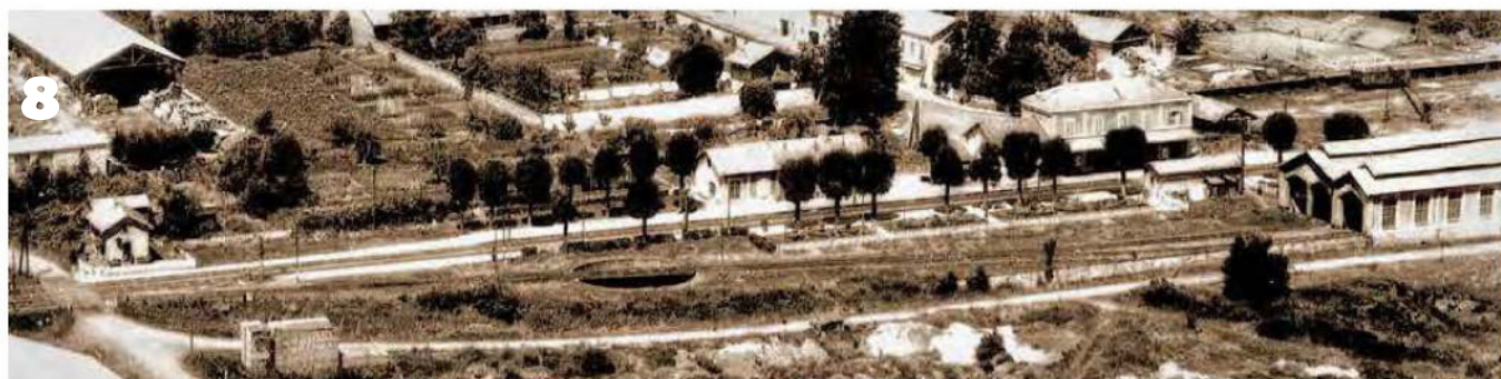
Vue aérienne de l'annexe-traction à la fin des années 1950 ou au début de la décennie suivante. L'une des voies est déjà déposée.
