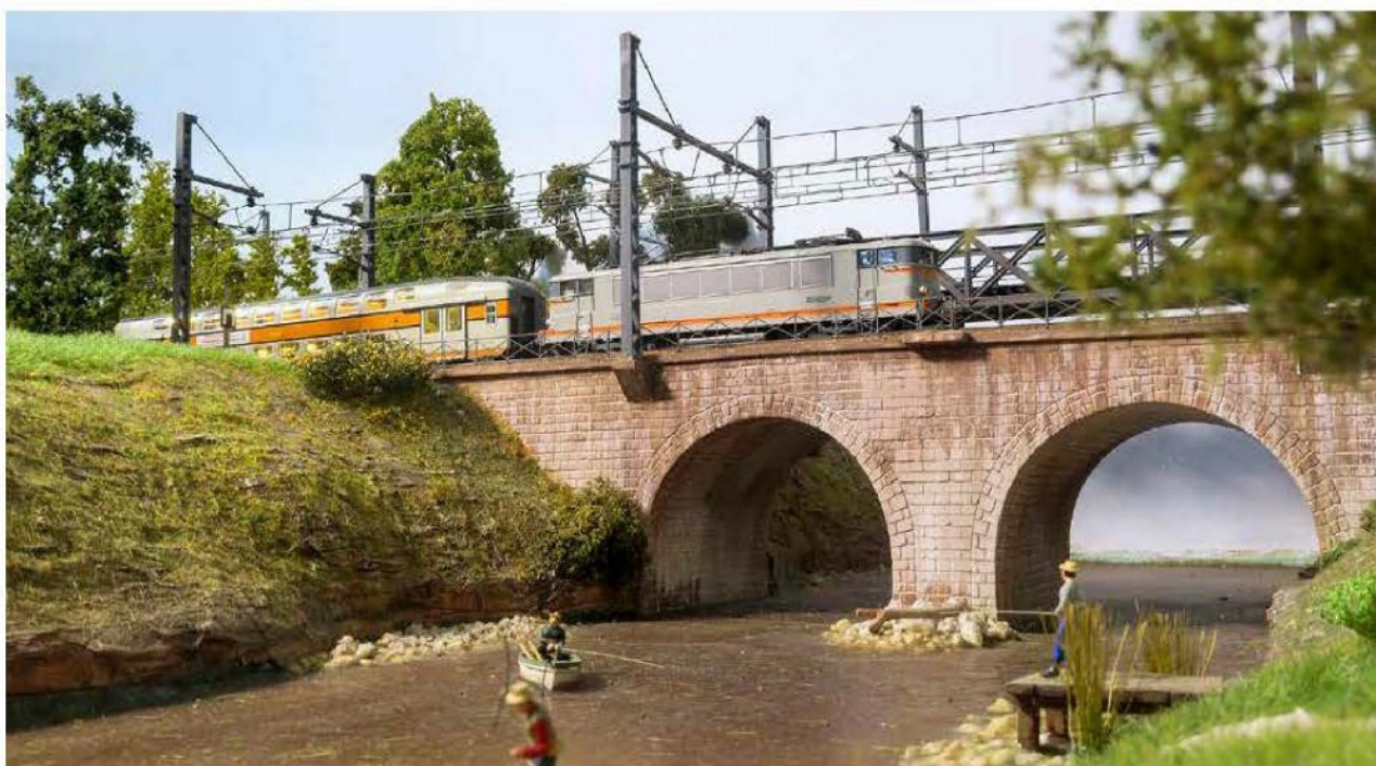
Le viaduc à deux arches maçonnées permet à la grande ligne Modane - Chambéry d'enjamber les eaux du Doron.
