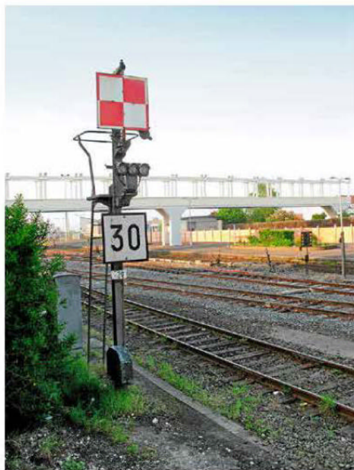
À l'extrémité de la voie 6, côté Saint-Pol, ce carré protège les aiguilles de sortie et un panneau impose un franchissement à 30 km/h.
