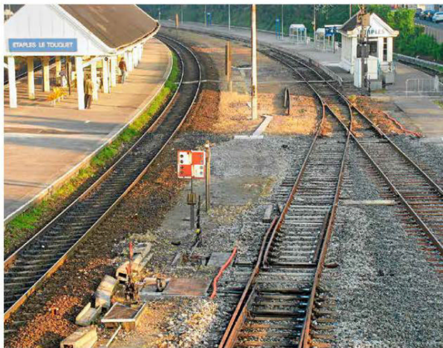
Sur voie de service, une aiguille d'ensablement protège la voie 4.
