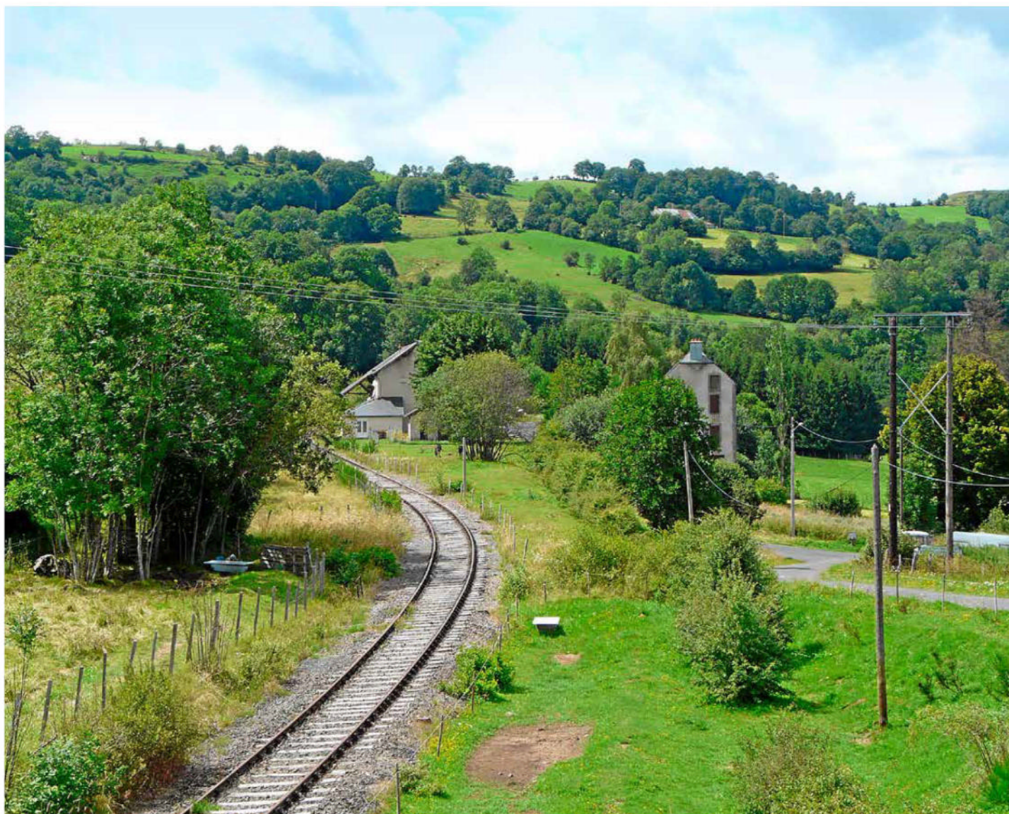
Vue générale du site de la gare, prise du passage routier supérieur, à 964 m d'altitude.
