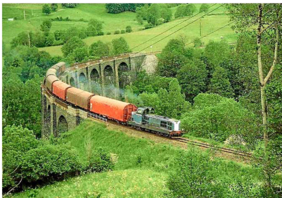
Franchissant le viaduc de Saint-Saturnin, ce train de bâchés descend vers Neussargues.
