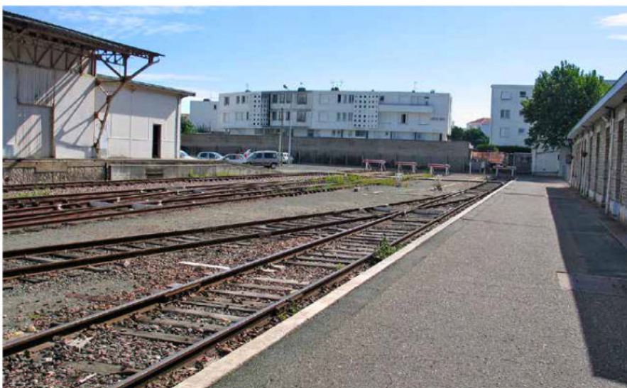
La plus longue des voies à quai est dotée d'une bretelle permettant de dégager la locomotive de ligne de sa rame. Une disposition à reproduire en modélisme.
