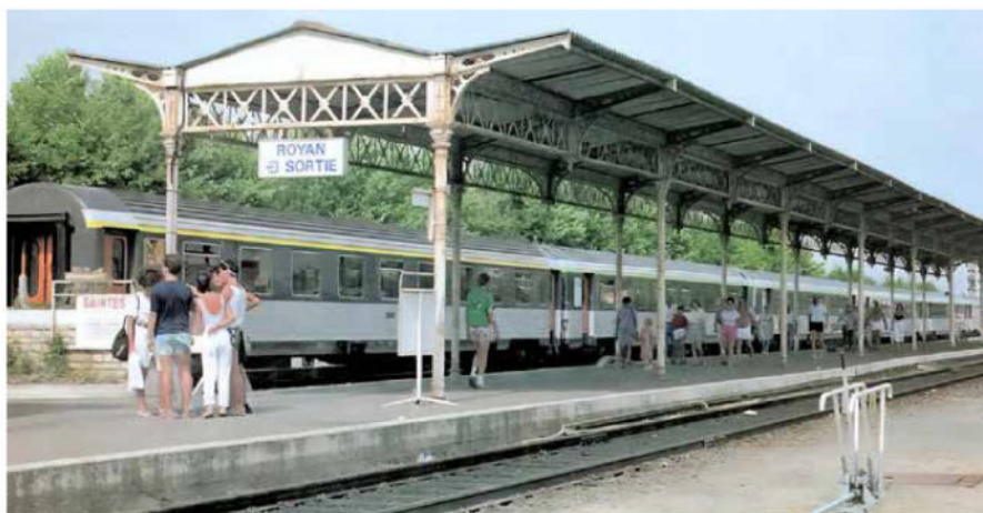
Le long abri parapluie a été déposé à la fin des années 80.
