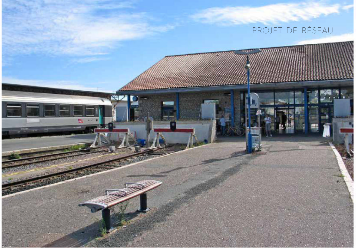
Face au B.V., deux voies en impasse.
