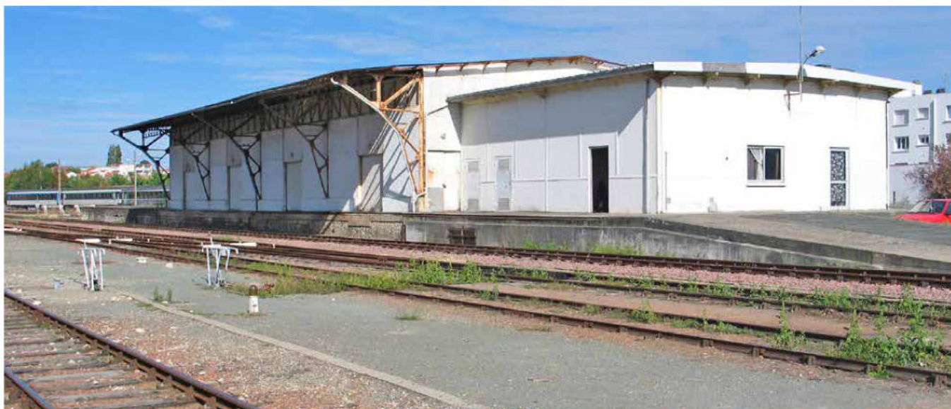
Dans les années 2000, la grande halle à marchandises n'est plus utilisée.
