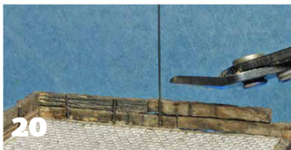
20 Une fois en place, les surlongueurs des ferrures sont éliminées.
