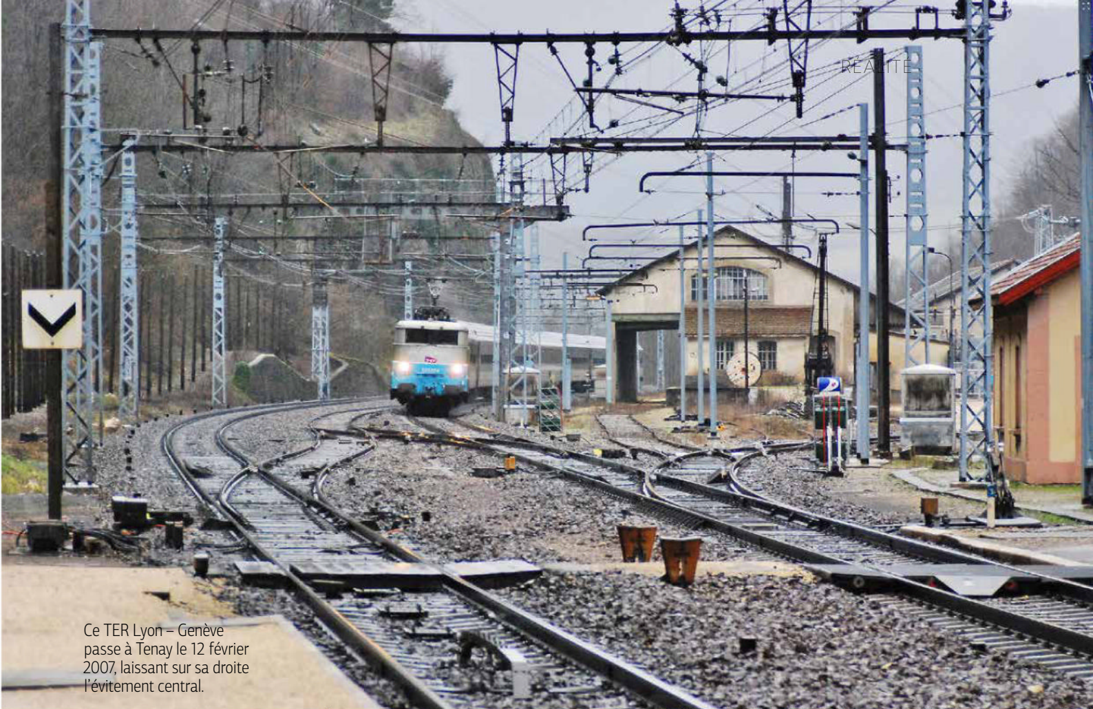
Contrairement à ce qu'on aurait pu imaginer, la potence ne porte pas le signal de protection des aiguilles de jonction avec la voie d'évitement, mais plutôt un carré violet, adressé aux marches de manœuvre.
