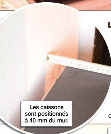
Mise à niveau du premier caisson.
