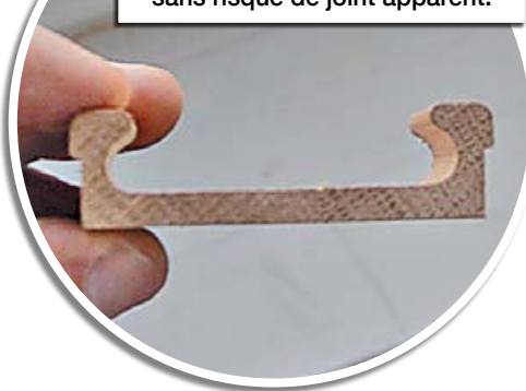
Le profil de la poignée. Le petit rebord sur l'extérieur permet de poser la poignée en applique sans risque de joint apparent.
