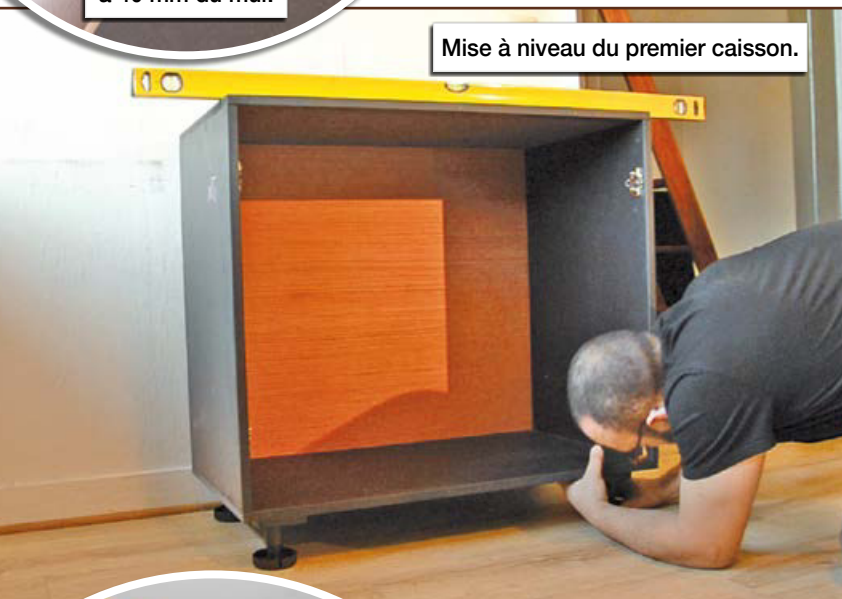
Les caissons sont positionnés à 40 mm du mur.
