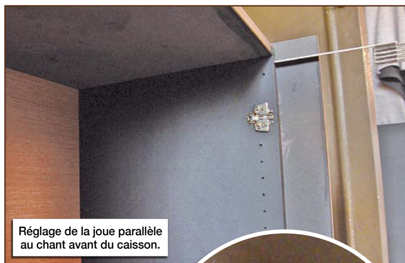
Les cales permettent de régler la joue.
