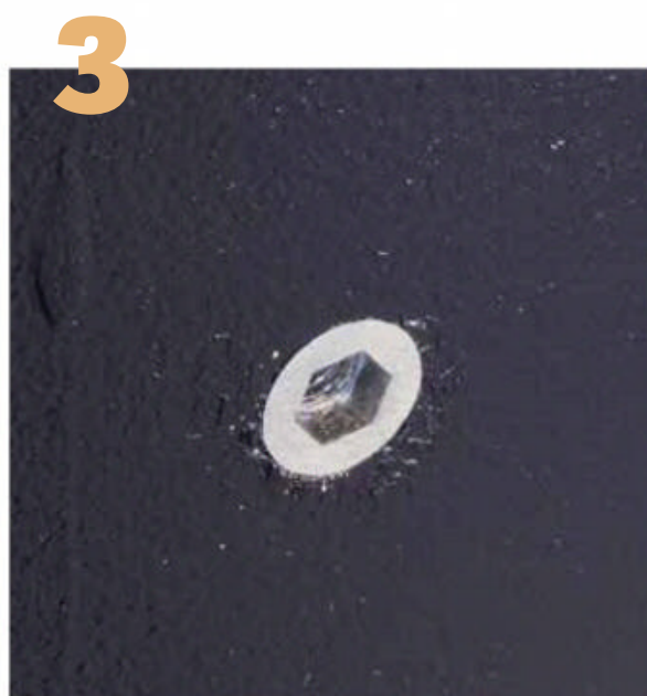
La collerette ne doit pas dépasser. Au besoin, un léger chanfrein peut être effectué auparavant.
