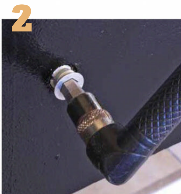
L'insert doit être vissé à fond, grâce à une clé à six pans.
