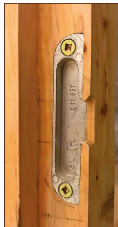
Entailles de paumelle comme celles de ces pièces de serrure ont été fraisées par le même procédé.
