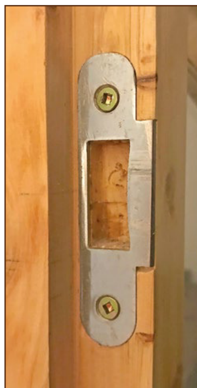
Entailles de paumelle comme celles de ces pièces de serrure ont été fraisées par le même procédé.
