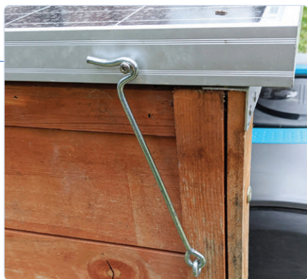
Figure 7. Comment empêcher le soulèvement du panneau par le vent.
