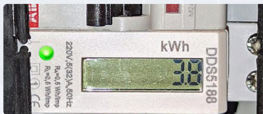
Figure 8. Ce compteur électrique à bas prix s'installe sur le rail DIN et enregistre l'énergie produite par la centrale sur balcon. L'écran affiche la production du premier jour de fonctionnement.
