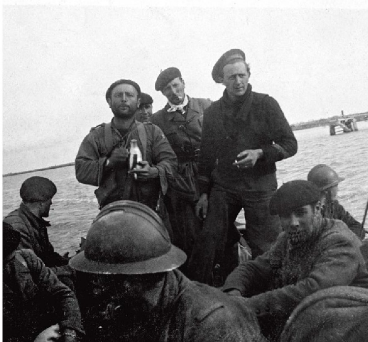
ECPAD/PHOTOGRAPHIE INCONNUE/215-32/AMICALE DU BA-198E RJ
