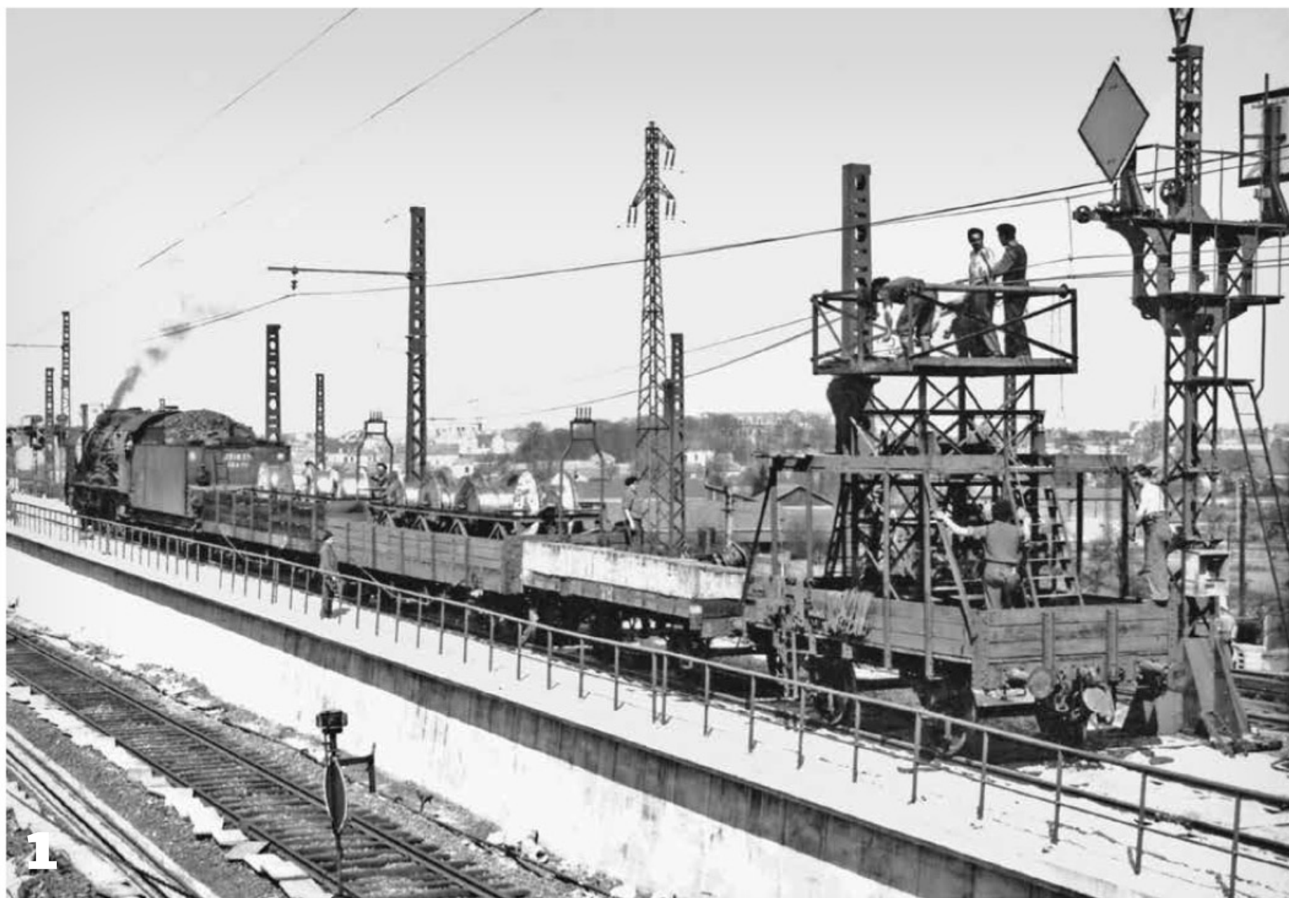
1: Déroulage de la caténaire 1500 V sur le saut-de-mouton de Dijon en 1949: la rame est tractée par la 231 K 35, et les anciens signaux hérités du PLM sont encore en place (SNCF, coll. G. Bachet).
