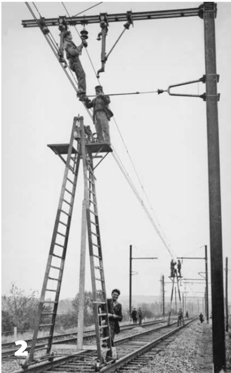
2: Montage de la caténaire sur un support ayant une chaise de relevage, ligne Dijon – Dole, 1956 (SNCF, coll. G. Bachet).
