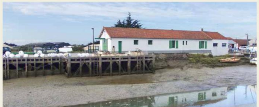
L'atelier des Phares & Balises de Noirmoutier-en-Île, tout en longueur. Ce site n'a jamais vu de voie ferrée, mais il s'y prête bien.
