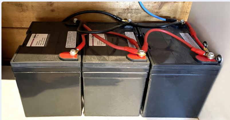
Figure 3. Trois batteries AGM 12 V, chacune de 36 Ah, sont câblées en parallèle pour stocker l'énergie dans l'abri de Klaus.
