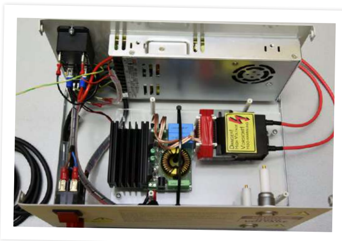
Figure 1. Générateur Lichtenberg (Photo : Ilse Joostens).
