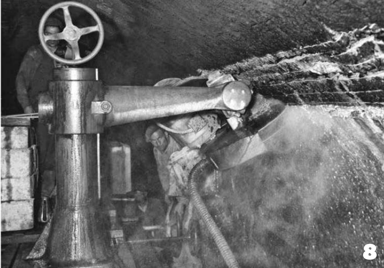
8: Entaillage à la scie de la voûte d'un tunnel en 1955 pour dégager le gabarit électrification.
