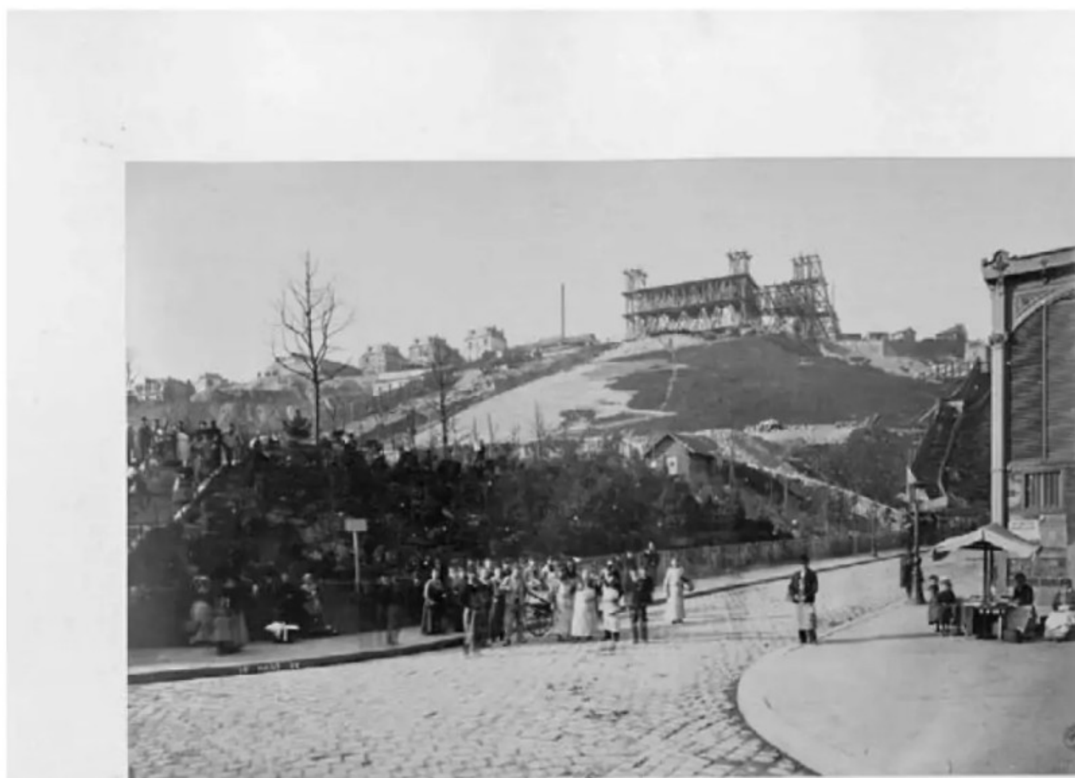
Chantier de l'église parisienne du Sacré-Cœur (1882), par Louis-Émile Durandelle.
