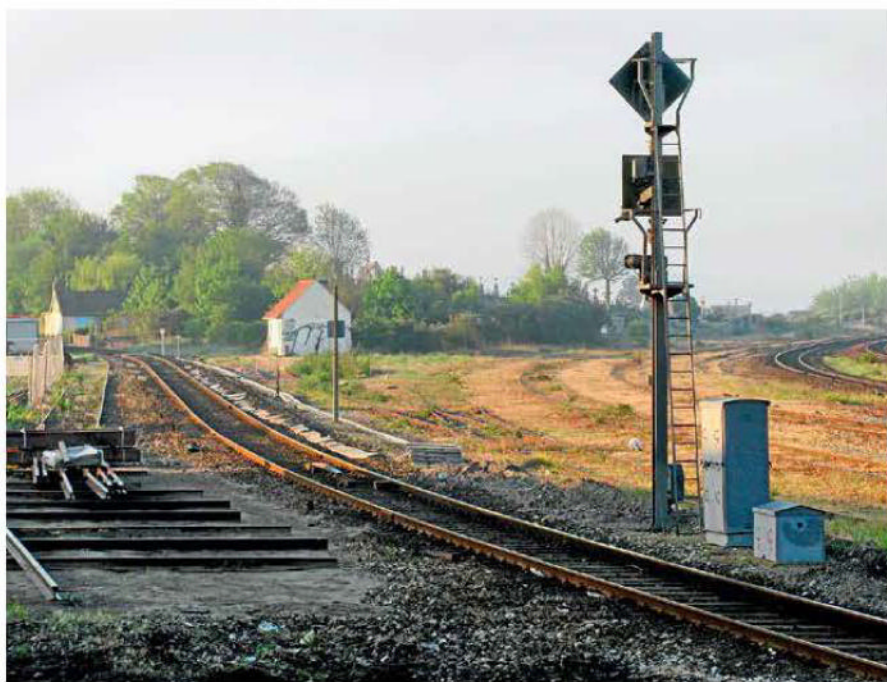
À l'entrée en gare de la ligne venant de Saint-Pol, un avertissement fixe et un carré de protection des aiguilles. Sur la droite, la double voie vers Abbeville et Amiens.
