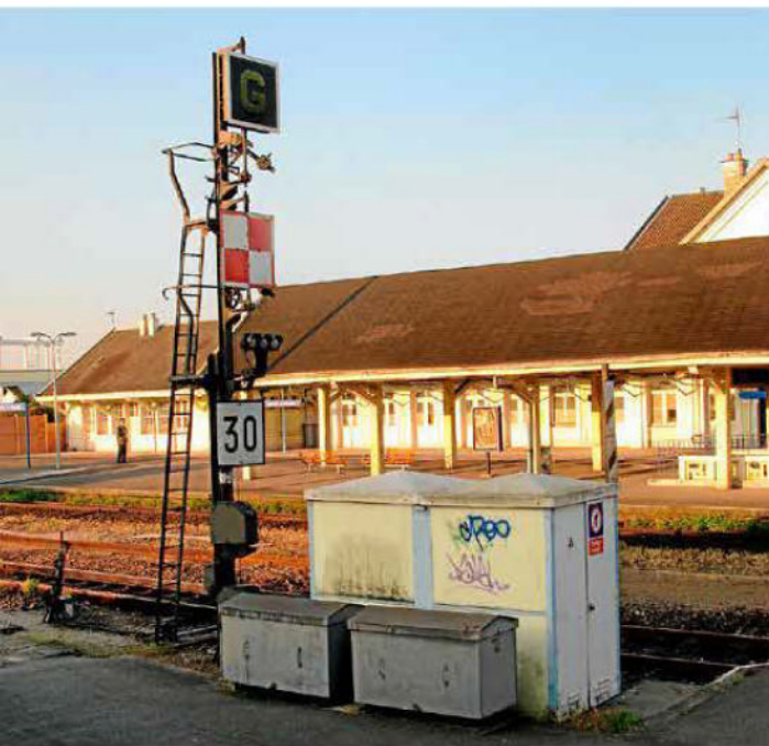
À l'extrémité de la voie 4, ce carré protège les aiguilles de sortie vers Saint-Pol.
