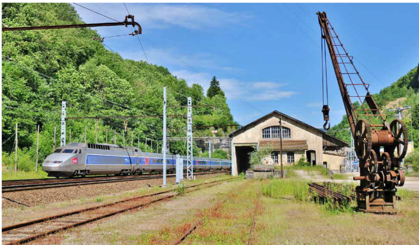
En 2005, la halle à marchandises est toujours debout.
