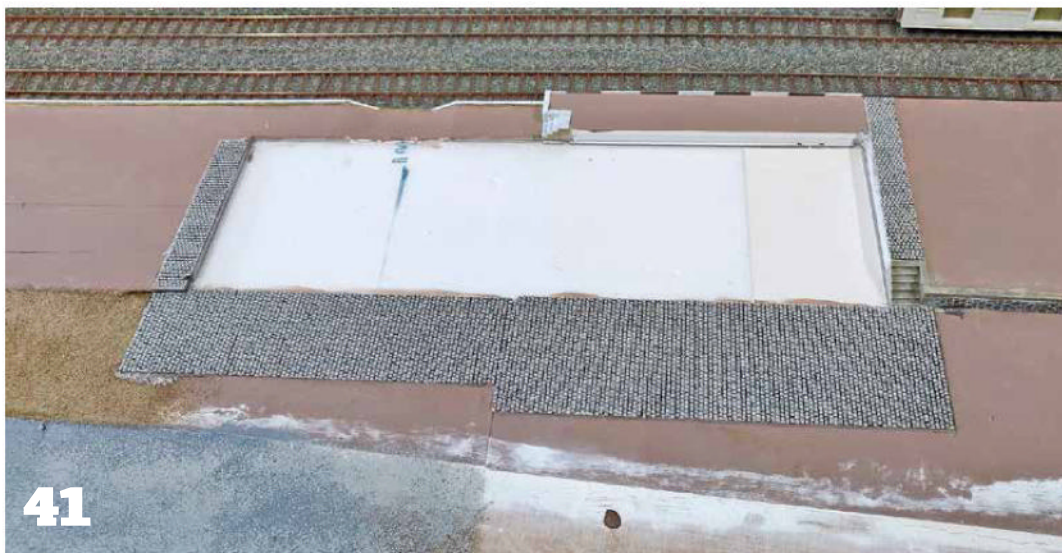
41: Mise en place des zones de pavés.
