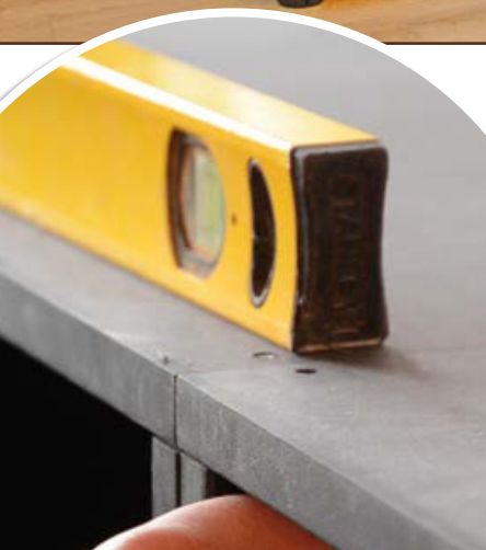
Je règle la hauteur du second caisson sur celle du premier.
