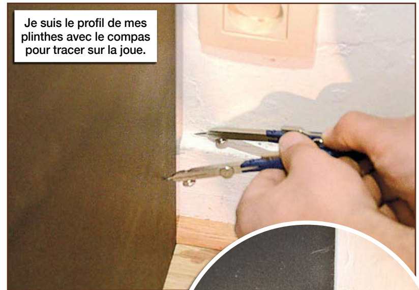
Le traçage du haut du caisson.
