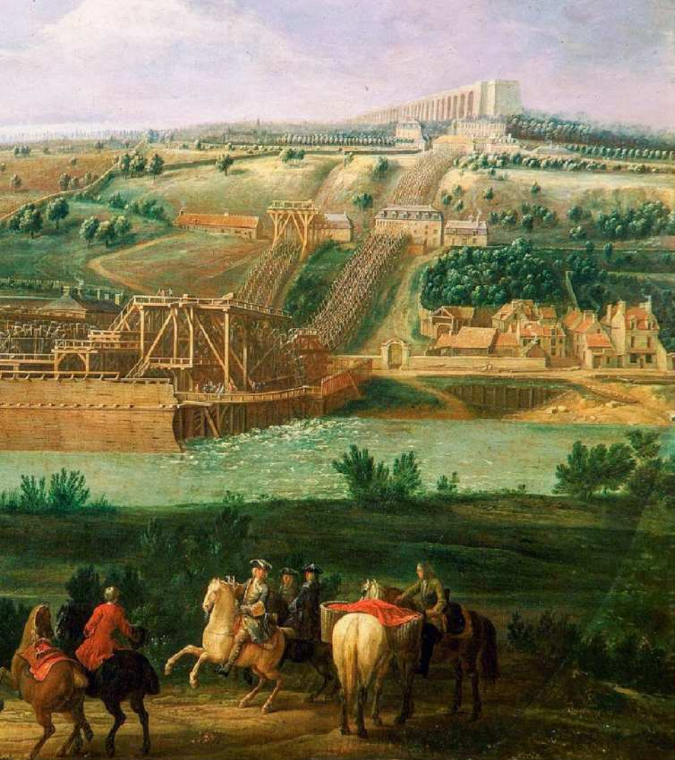
Ingénierie La machine installée par Louis XIV en 1682 pompait l'eau de la Seine pour alimenter en eau les parcs de Marly et de Versailles. Vue de la machine de Marly , de Pierre-Denis Martin (1663-1742).
